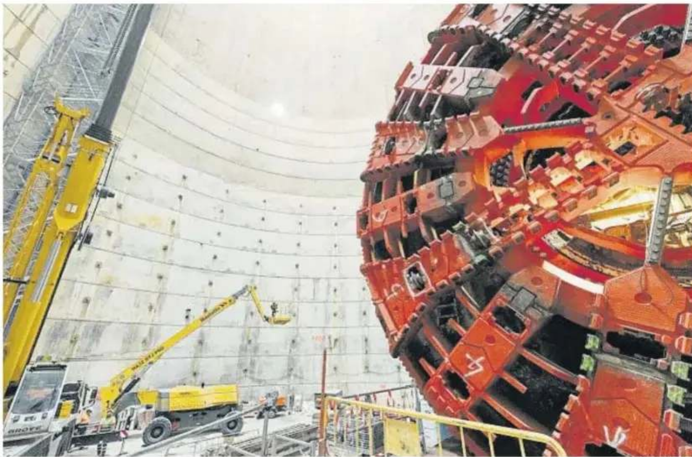
Los dientes de la gigantesca rueda de corte de la tuneladora ya se han puesto a punto en el pozo de Mandri
