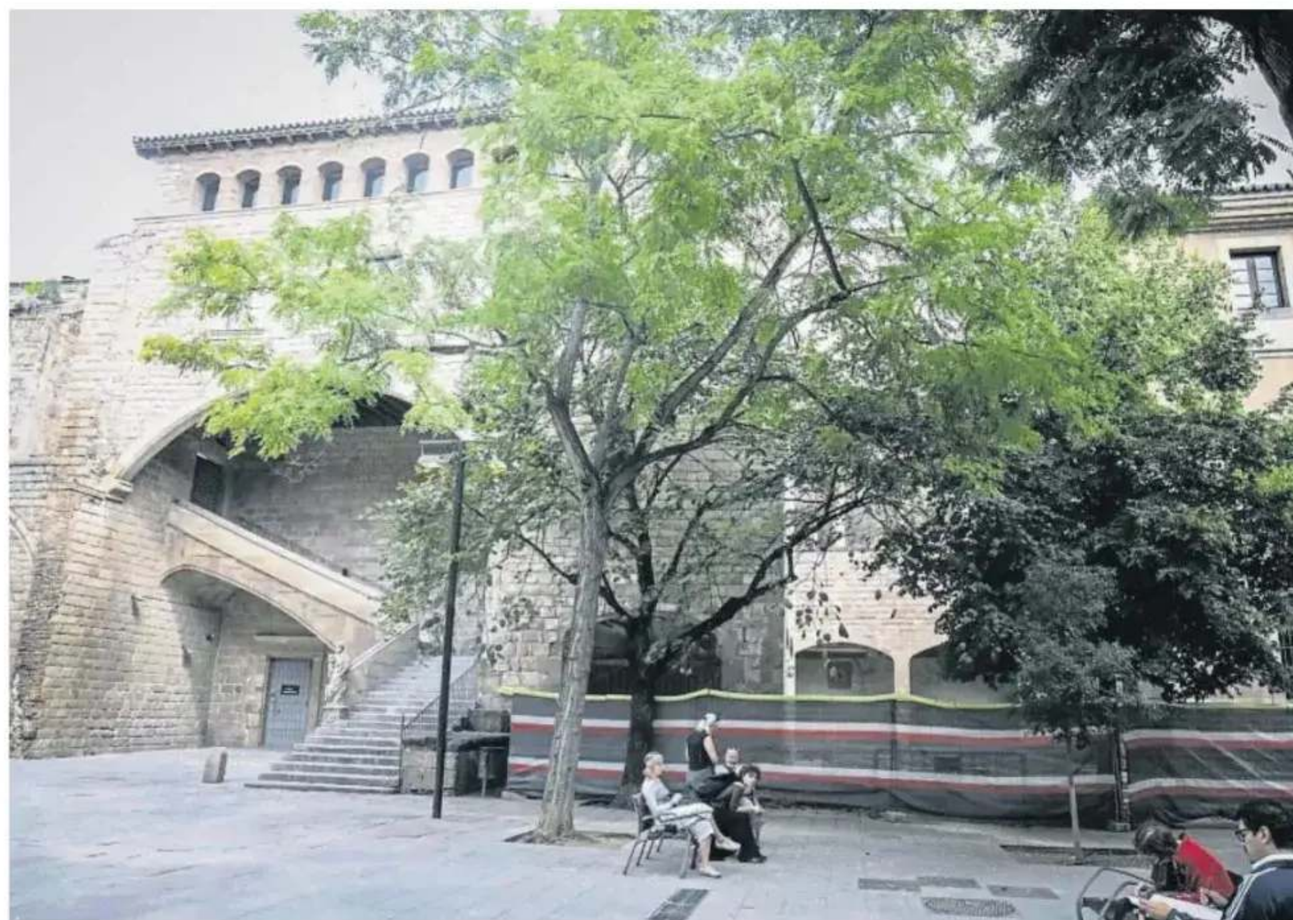
Las obras del pasaje que unirá el recinto del antiguo hospital de la Santa Creu con la plaza de la Gardunya estarán listas a principios de año
