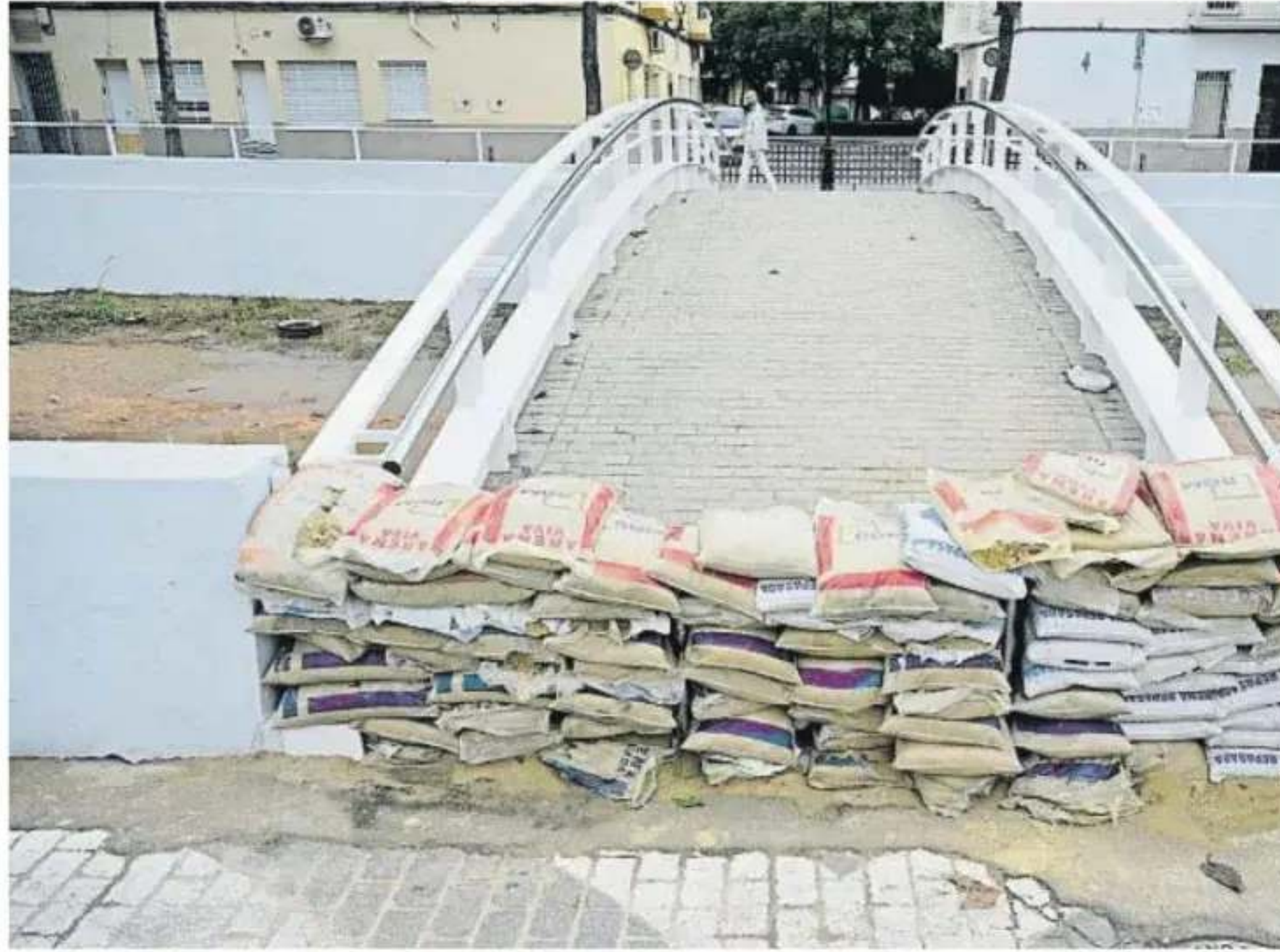
Sacos de arena colocados en un puente de la localidad de Aldaia, que registró fuertes lluvias.
